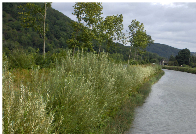
Illustration 42 : Vue de la berge en 2008 [Source CETMEF]
