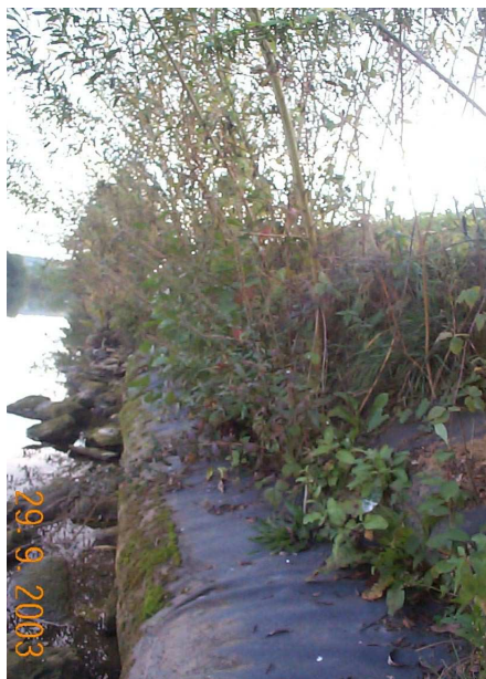
Illustration 38: Berge deux ans après les travaux [Source VNF]
