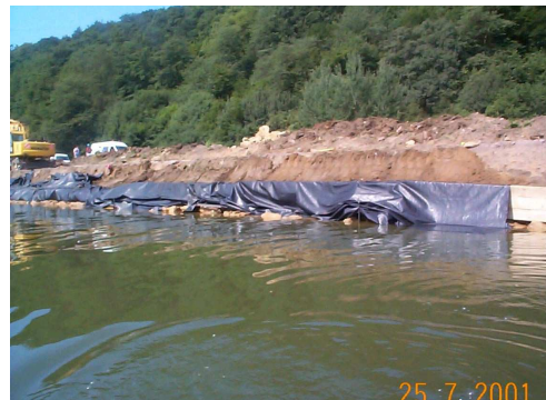
Illustration 37 : Coffrage végétal [Source VNF]
