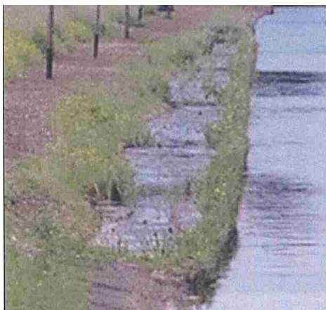
Illustration 27 : Vue après travaux [Source VNF]
