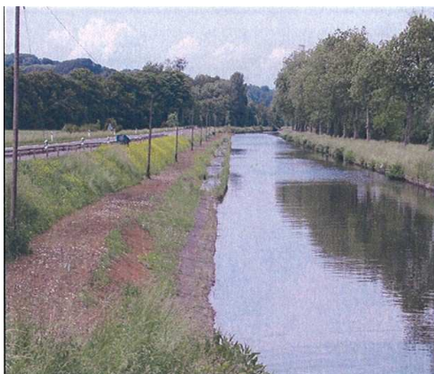
Illustration 32 : Fin des travaux [Source VNF]
