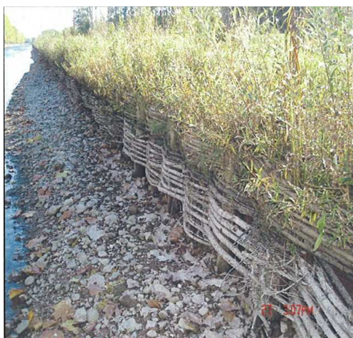
Illustration 21 : Vue du tressage et de la végétation [Source VNF]
