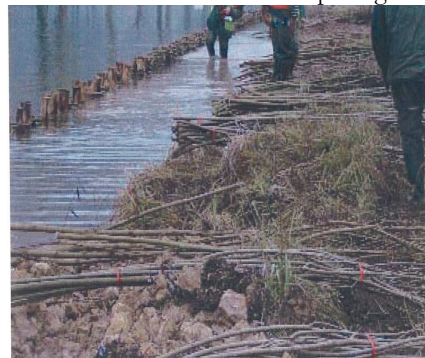
Illustration 20 : Fagots pour le tressage [Source VNF]
